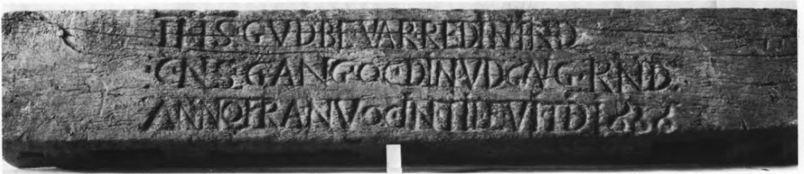
Fig. 3. Dørhammer med årstallet 1666, angiveligt hidrørende fra den nedrevne kirke. Indmuret over døren mellem våbenhus og kirkerum (s. 346). N. J. Termansen fot. 1949. — Lintel from 1666, presumably coming from the demolished church. Inserted over the doorway between the porch and the church.
